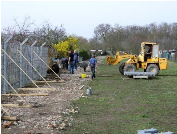
Neubau des Zaunes durch die neue Kleingartendurchfahrt, Foto: Rudolf Neusch, 02.04.2016
